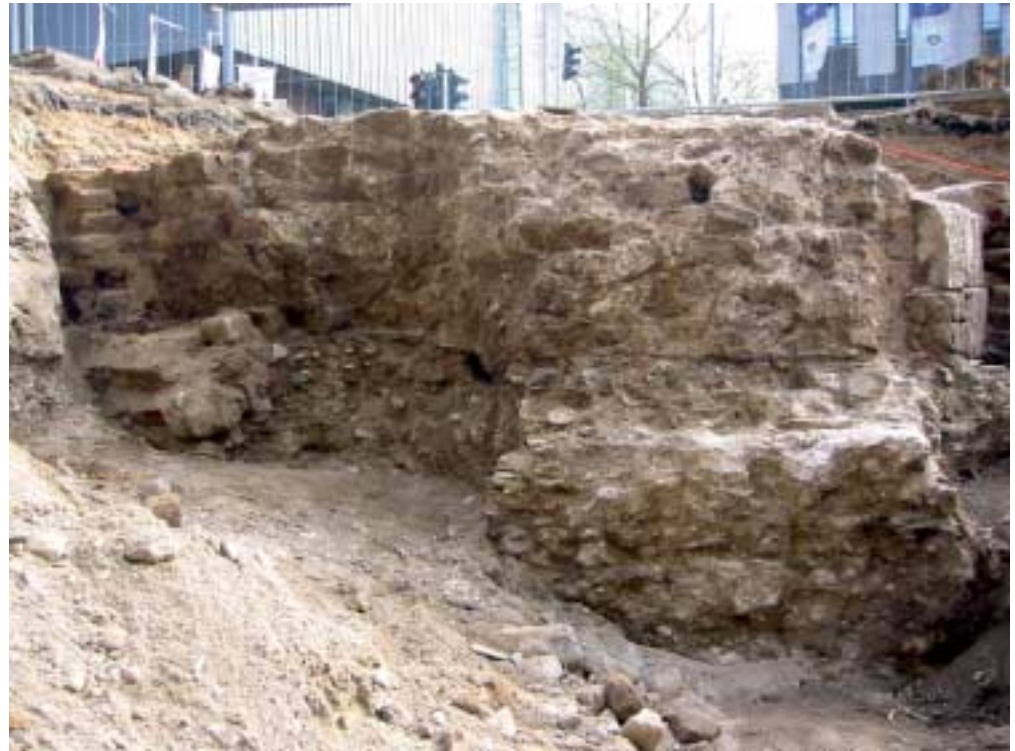
4 Das Fundament des erzbischöflichen Palastes (12. Jahrhundert) ruht auf der rheinseitigen römischen Stadtmauer (spätes 1. Jahrhundert n. Chr.), Ausgrabungsbefund 2004
